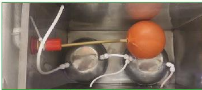
مخزن بهداشتی بعد از نصب شیرآلات نی‌دار
