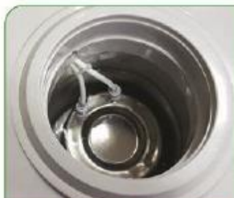
مخزن بهداشتی بعد از نصب شیرآلات نی‌دار
