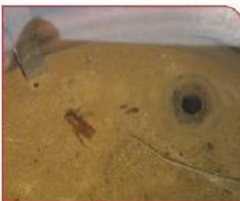
قبل از نصب شیرآلات نی‌دار (وجود حشرات داخل مخزن)
