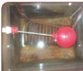
قبل از نصب شیرآلات نی‌دار (آلودگی‌های مخزن)
